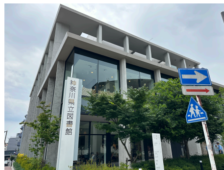
写真6 県立図書館新棟
