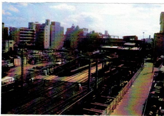
【23-3】相模大野駅周辺 1993(平成5)年 駅ビル建設の工事が始まり、鉄骨が建ち始めているのがわかる。南口(左)にも、ビルが目立ってきた。北口(右)駐車場も立体化している。
