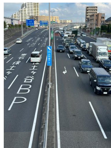
図 11 高架部と側道の合流地点
