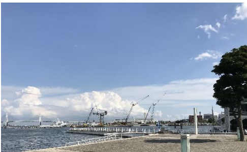
ハンマーヘッド 建設中 2018年9月18日 13時56分 撮影
