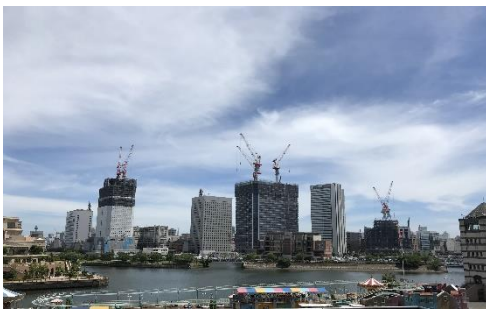
横浜市庁舎 建設中 2018年7月3日 13時14分 撮影
