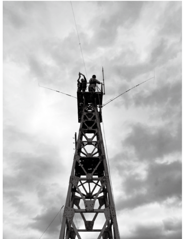
写真4 アンテナ設置作業の様子
