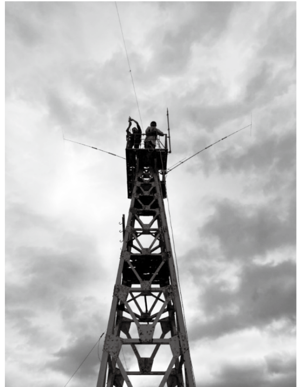
写真4 アンテナ設置作業の様子
