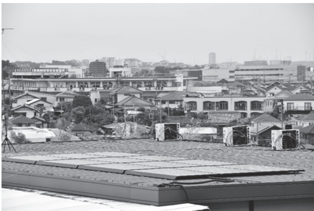
図 15 宮内建設 太陽光発電設備 4.4kW
