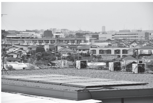
図 15 宮内建設 太陽光発電設備 4.4kW
