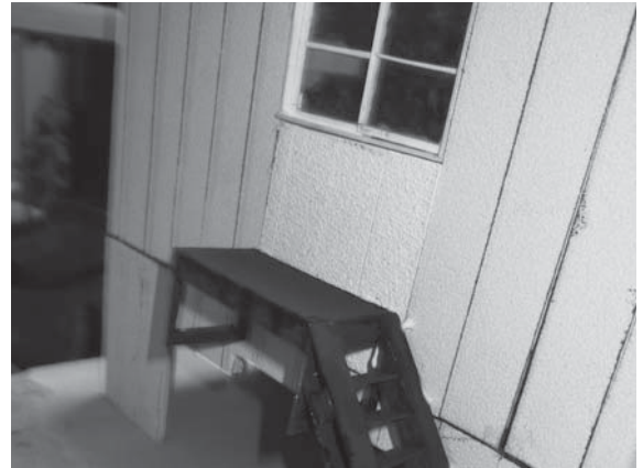
階段の先にあった扉はふさがれ、窓に改築されている
