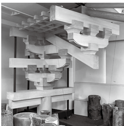
写真5 初重斗組み部分模型
