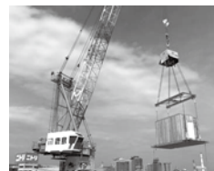
(図3) ユニットの揚重状況
