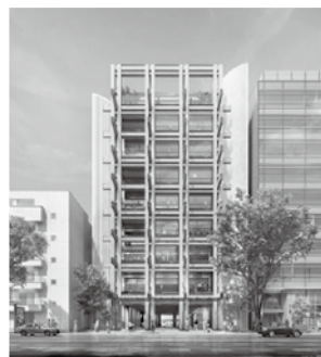
（図9）鹿島東北支店ビル外観
