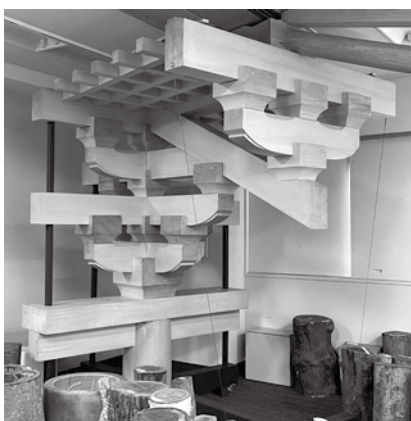
写真5 初重斗組み部分模型
