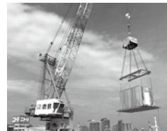
(図3) ユニットの揚重状況
